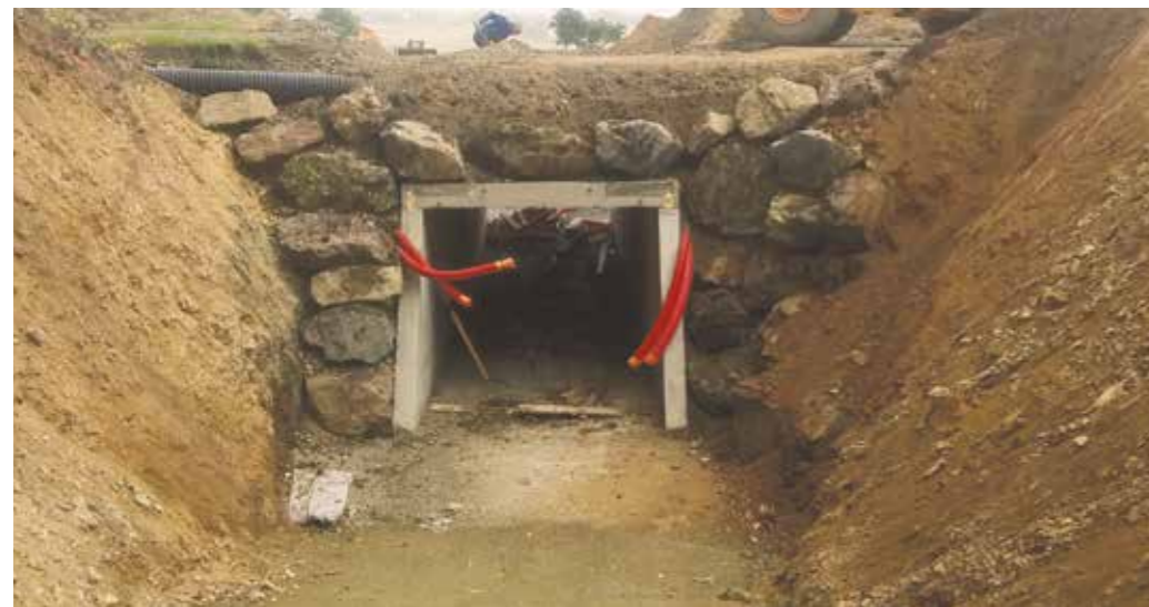
Pont cadre pour passages animaux Longueur 14 m Largeur 2,20 m Hauteur 2 m
