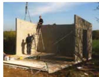
Exemple de réalisation d'un garage en préfa.
