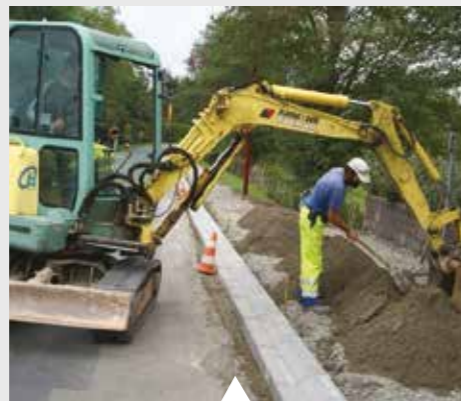
Pose de bordures TP
