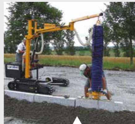
Pose de bordures TP mécanisée
