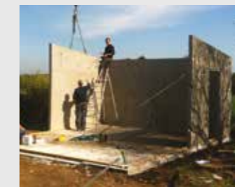
Exemple de réalisation d'un garage en préfa.
