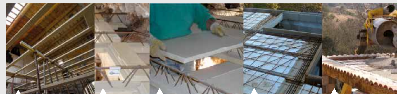
Réalisation des arases, réglage des appuis
