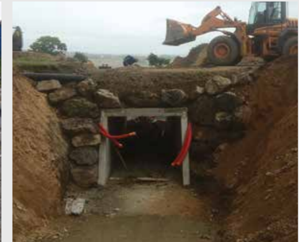
Pont cadre pour passages animaux Longueur 14 m Largeur 2,20 m Hauteur 2 m
