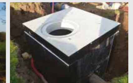
Ouvrage de régulation posé sur chantier.
