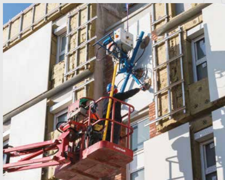
Pose en bardage avec isolation
