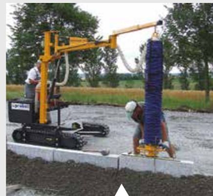
Pose de bordures TP mécanisée
