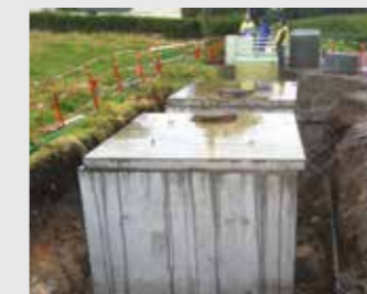
Bâche de stockage pour eaux usées avec traitement H2S.
