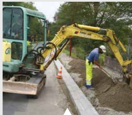
Pose de bordures TP
