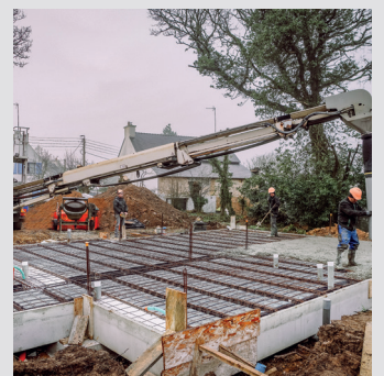
Gain de temps à la mise en œuvre
