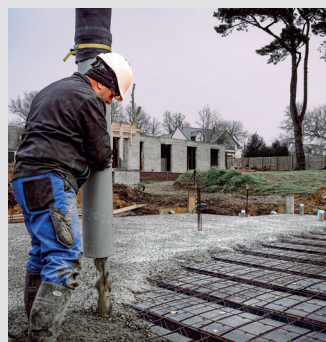
Sécurité renforcée à la mise en œuvre
