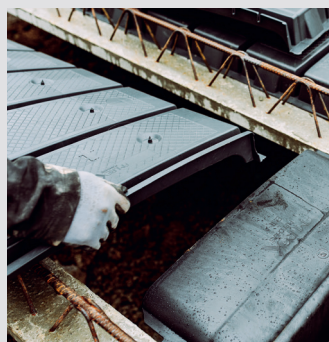
Facilité à la mise en œuvre avec about tiroir
