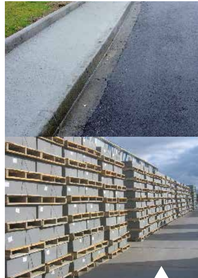
Stockage des bordures TP
