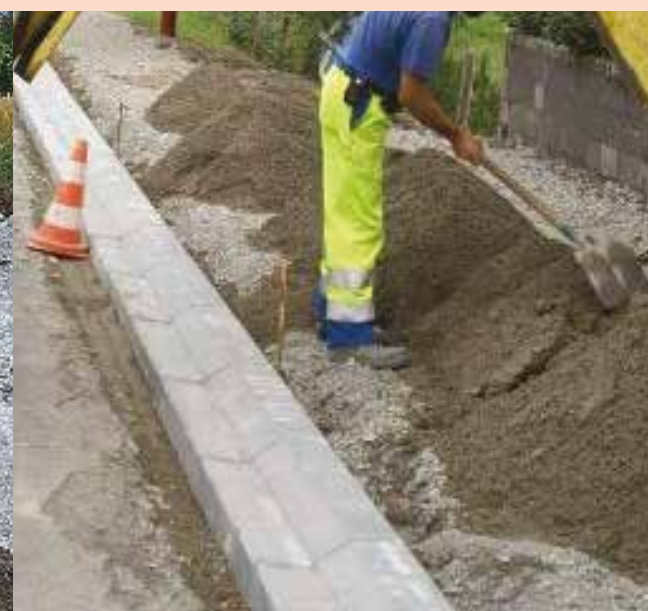
Pose de bordure T.P. non normalisée
