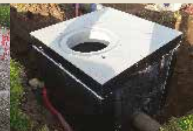
Ouvrage de régulation posé sur chantier.
