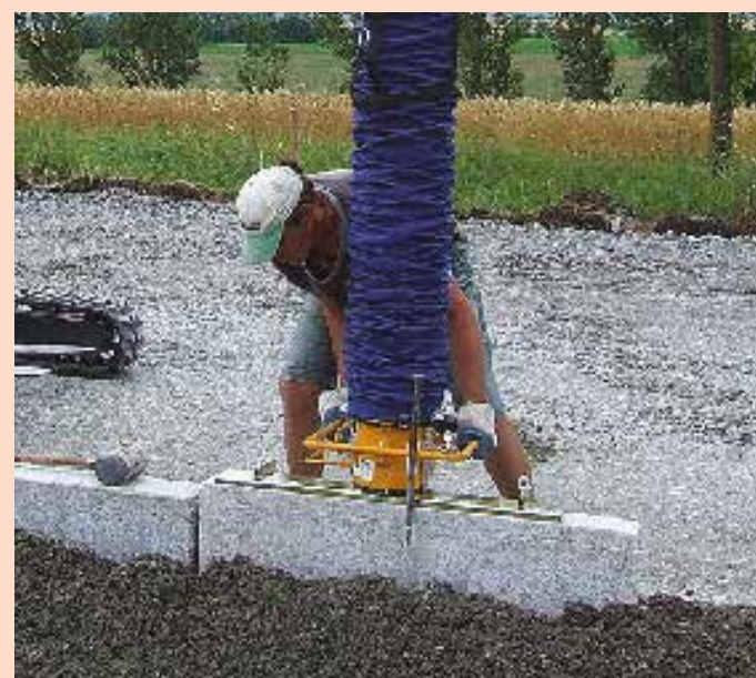
Pose de bordure T.P.
