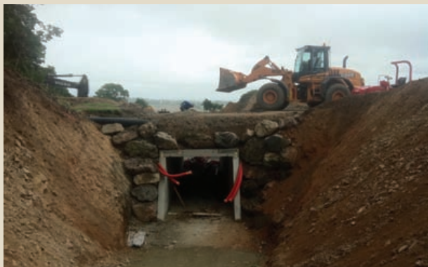
Pont cadre pour passage animaux 14 m L. x 2,20 m l. x 2 m h.
