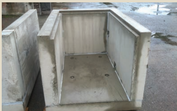
Courette anglaise préfabriquée avant pose. (Ventilation des caves de collectifs).
