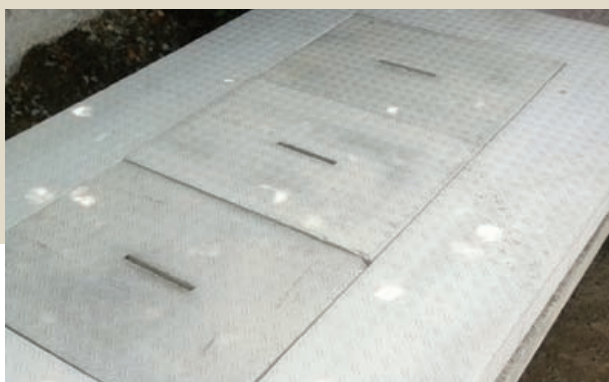
Dalle anti-dérapante en béton matricé avec trappes.
