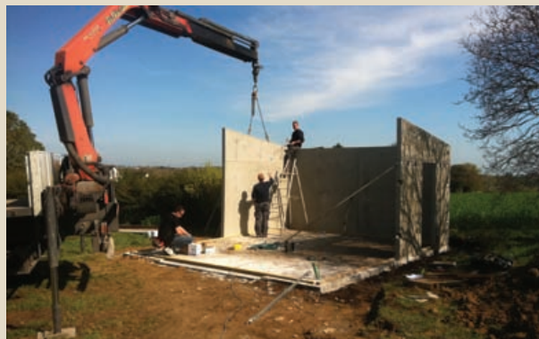
Exemple de réalisation d'un garage en préfa.
