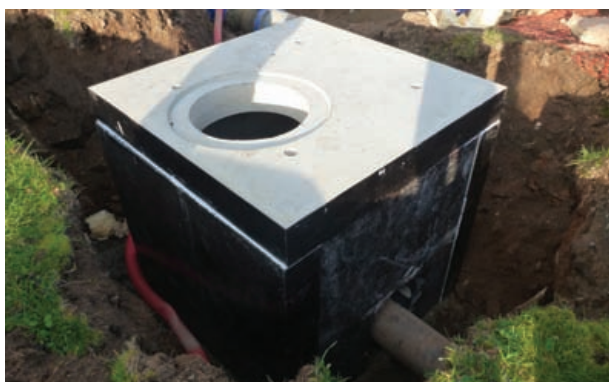
Ouvrage de régulation posé sur chantier.
