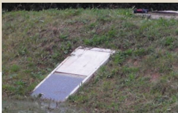
Avaloir à eau posé.
