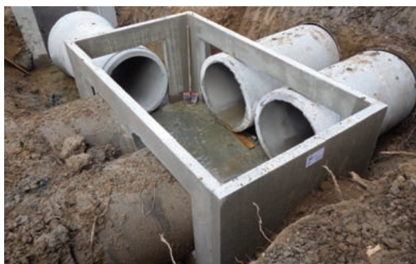
Regard multi-branchements posé sur chantier.
