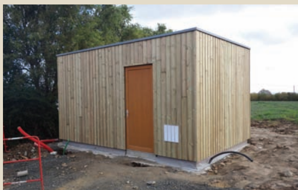
Local surpresseur avec bardage.
